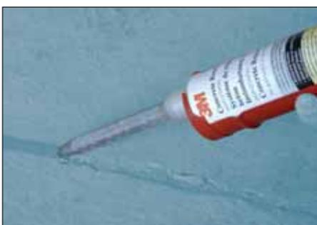
*Reparatur von Rissen und Löchern in Betonböden
